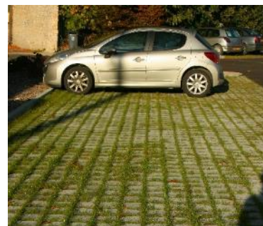
Pavés jointés en herbe
