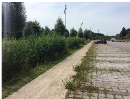
Pavés jointés de graviers en cours de végétalisation
